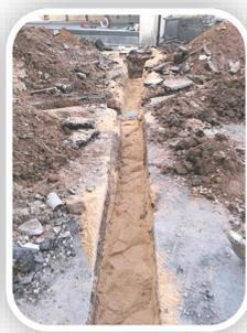
Lors des travaux dans le cadre de la salle de quartier, il s'est avéré que les **réseaux d'eaux pluviales** et **eaux usées** étaient très abîmés (écoulements inexistantes ou bouchés). L'entreprise **BONNEAU-TRAHAY**, située à Montreuil-Poulay, a réalisé la réfection des réseaux pour un montant de **3 594,13 € HT**.
